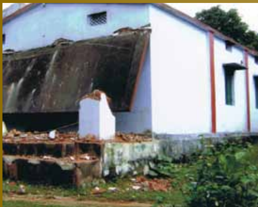
Das demolierte Gemeindehaus
